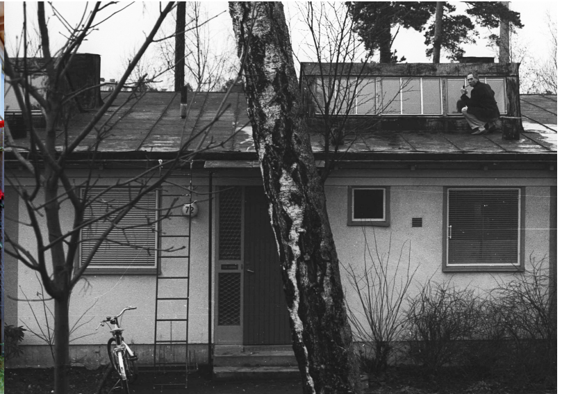
Fasadbild från början av 60-talet där färgen på karmen syns i kontrast till den vita bågen.
